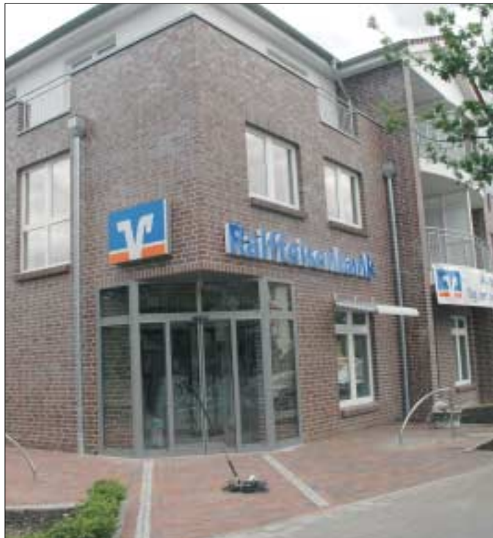
Unter Hochdruck werden noch letzte Arbeiten erledigt und dann präsentiert sich freundlich und einladend die neue Geschäftsstelle der Raiffeisenbank in dem Eckhaus Ofenerdieker Straße / Ecke Paul-Tantzen-Straße.
