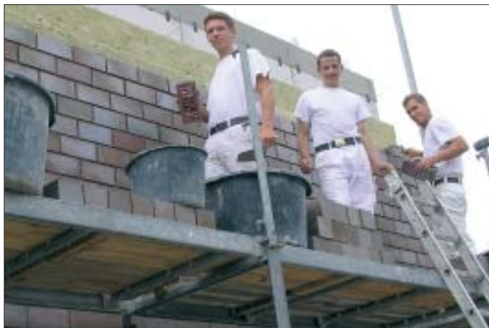
Auf dem Foto v.l.n.r.: Die Lehrlinge Christopher Liedtke, Alexander Harbers und Marcel Blisgeyn setzen auf eine solide und gute Ausbildung. Foto: Bau Müller
